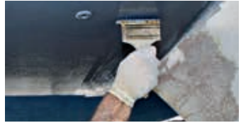
Overstryk Hempel's High Protect II i modsat retning med pensel
