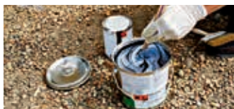
Rør blandingen grundigt
