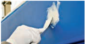
Udfyld ujævnheder med spartel
