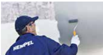
Påfør Hempel's Underwater Primer på overfladen
